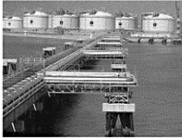
Figure 5.4.1 Incheon LNG terminal
