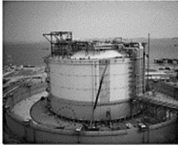
Figure 5.4.2 LNG storage tank
